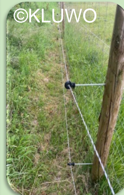
Beispiel für aufgerüsteten Drahtgeflechtzaun
